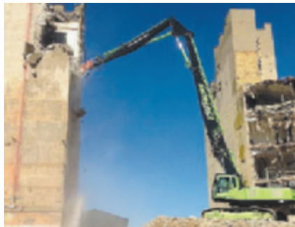
Un intervento di demolizione
