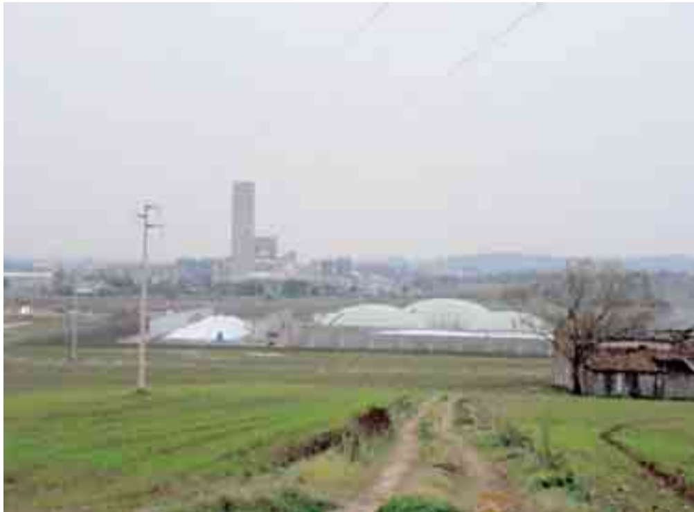
L'impianto di biogas a Raibano con, sullo sfondo, l'inceneritore dei rifiuti
