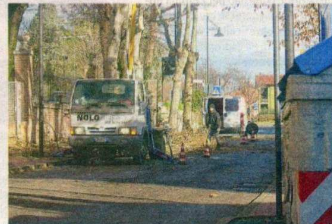
I lavori di potatura a Ospedaletto
