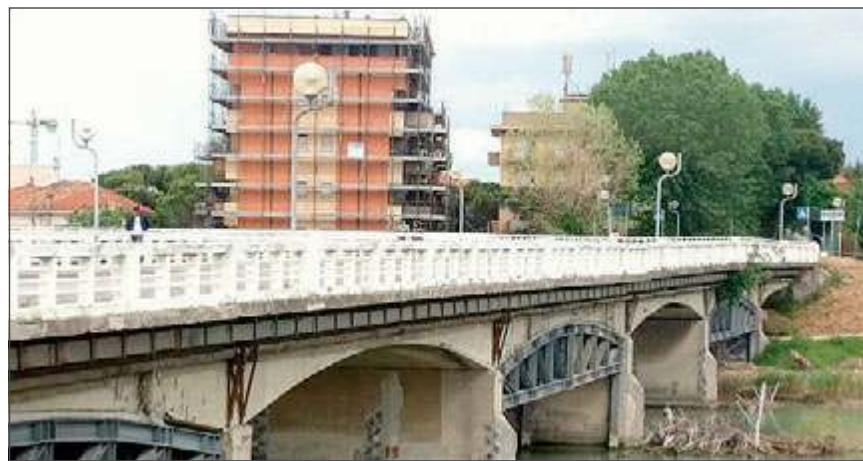
Il ponte di via Coletti. Da novembre a fine gennaio è previsto il senso unico alternato poi il cavalcavia verrà abbattuto
