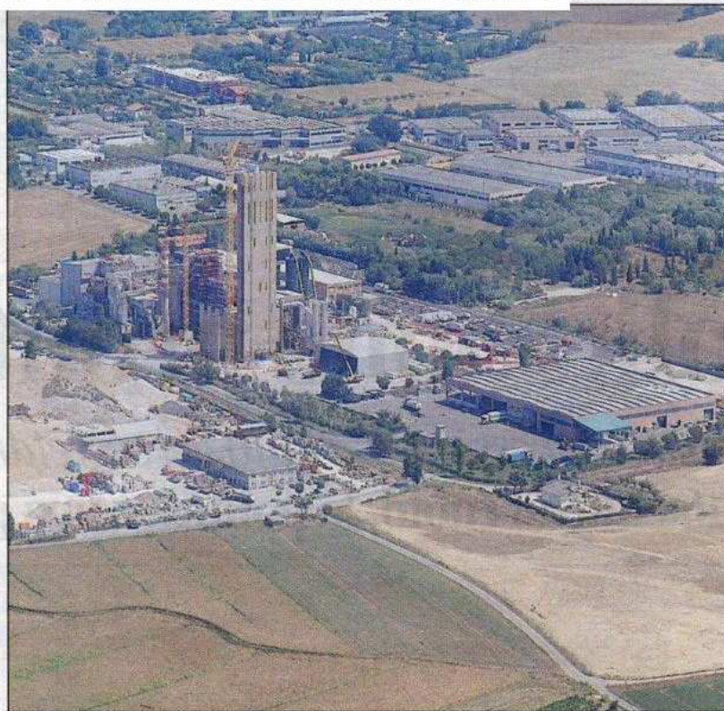
A Raibano attualmente una struttura in pvc è adibita a stoccaggio rifiuti
