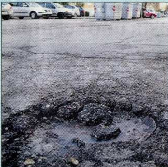
Un esempio di possibile intervento di manutenzione
